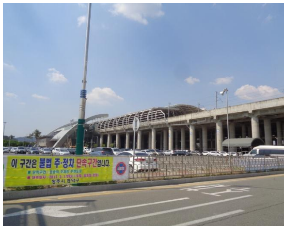
교량 측면 전경
